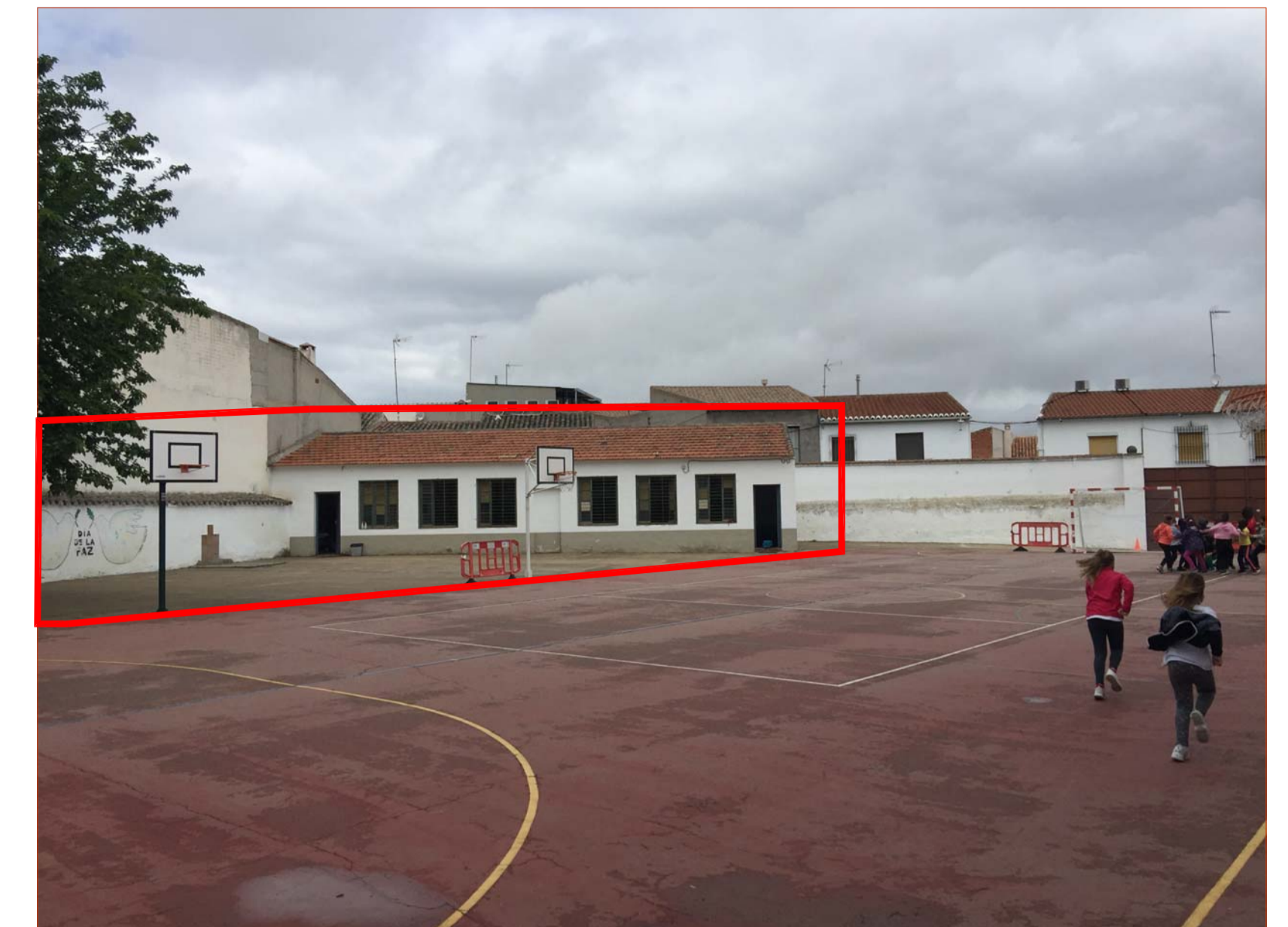
ZONA DE ACTUACIÓN CON DEMOLICIÓN PREVIA DEL EDIFICIO-GIMNASIO ACTUAL
